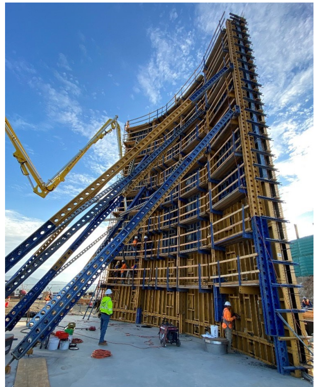
Concrete Pour for First Reservoir Wall Section
